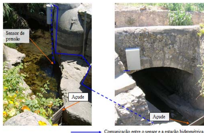
Figura 4- Estação hidrométrica automática na ribeira de Sassoeiros. À esquerda a visão a montante do açude; à direita a visão a jusante do açude
